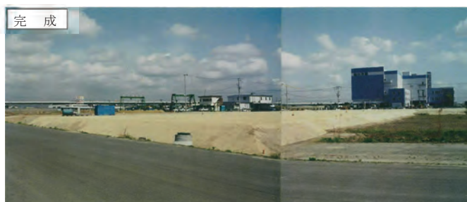
①47街区 整地工事
