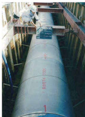
④ポートセンター中央線 下水道工事
