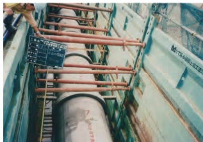
④ポートセンター西線 下水道工事
