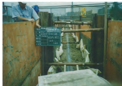
⑤海見える大通り線 下水道工事
