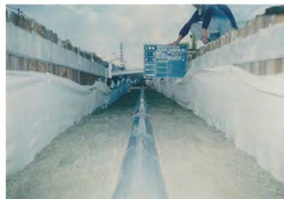
⑤ポートセンター中央線 下水道工事
