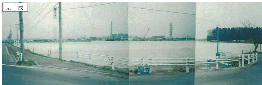
①12街区 整地工事
