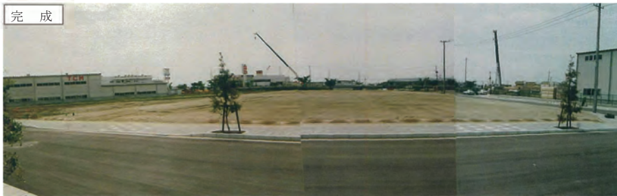
①56 街区 整地工事
