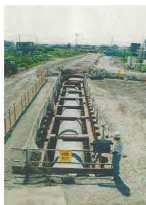
④ポートセンター西線 下水道工事
