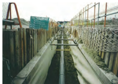
⑤鶴ヶ谷仙台港線 下水道工事
