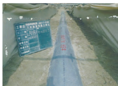
⑤区画道路 18-1 下水道工事
