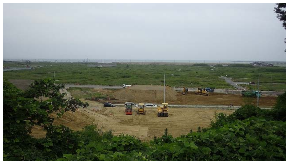
①現在造成工事が進められている
