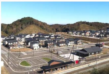
東松島市野蒜地区(令和元年5月)
