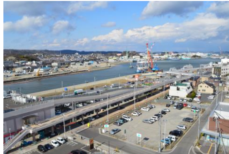
津波避難デッキ全景
