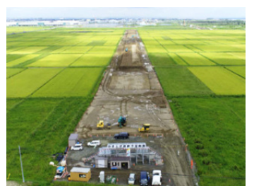
嵩上げ道路の施工状況
