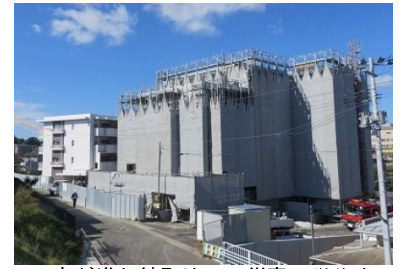
工事が進む錦町地区の災害公営住宅
