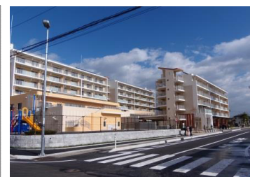
多賀城市桜木地区の災害公営住宅
