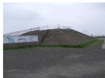
閑上地区宅地嵩上げ現地確認場
