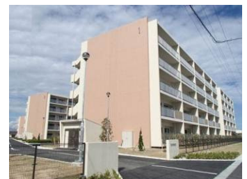
完成し、入居が決まった亙理町「荒浜西木倉地区」の災害公営住宅
