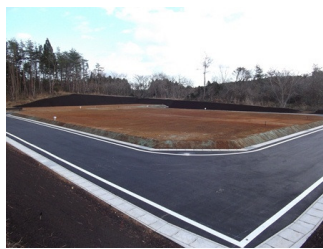
造成工事が完了した藤浜団地
