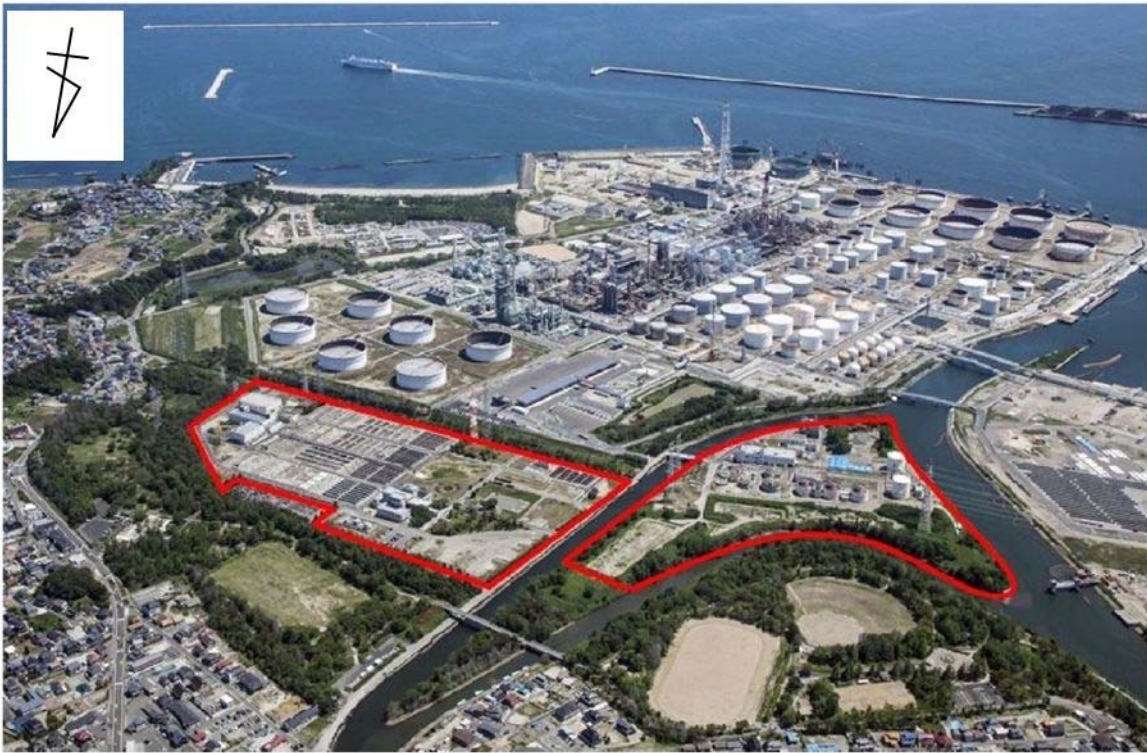
仙塩浄化センター全景図（赤線部分が敷地）
