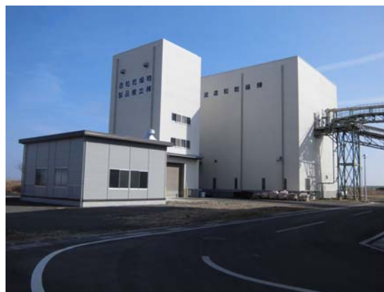
(汚泥燃料化施設)
