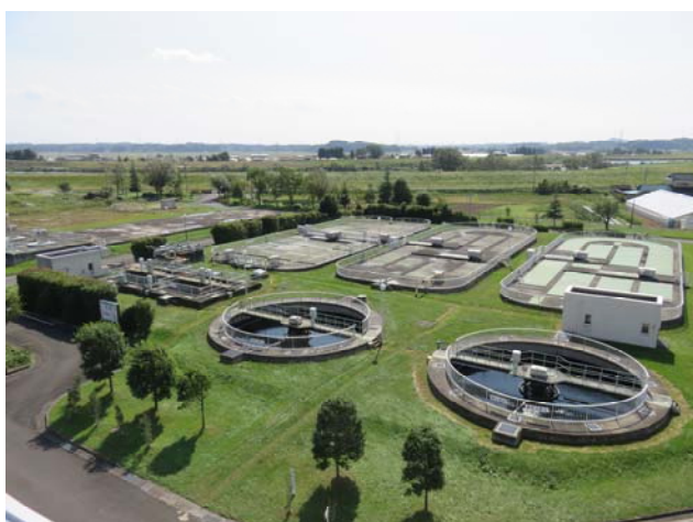
(オキシレーションディッチ)
