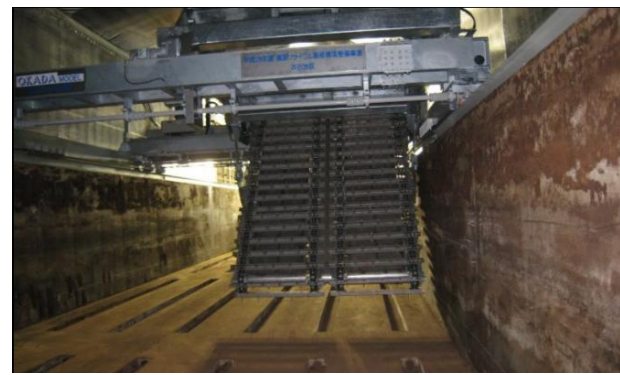
資源リサイクル畜産環境整備事業により機能保全を図った「気仙沼市本吉有機肥料センター」
