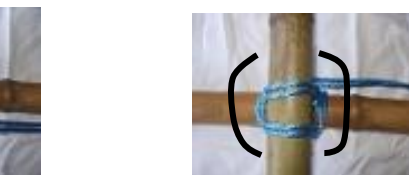
②輪の中にロープの端を通し引っ張る。
