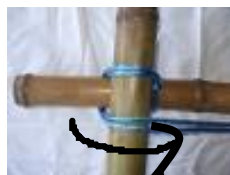
①下の竹にロープの輪の方を通す。
