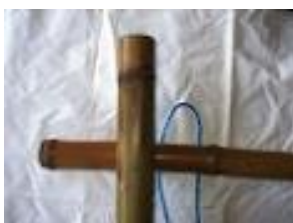
①下の竹にロープの輪の方を通す。
