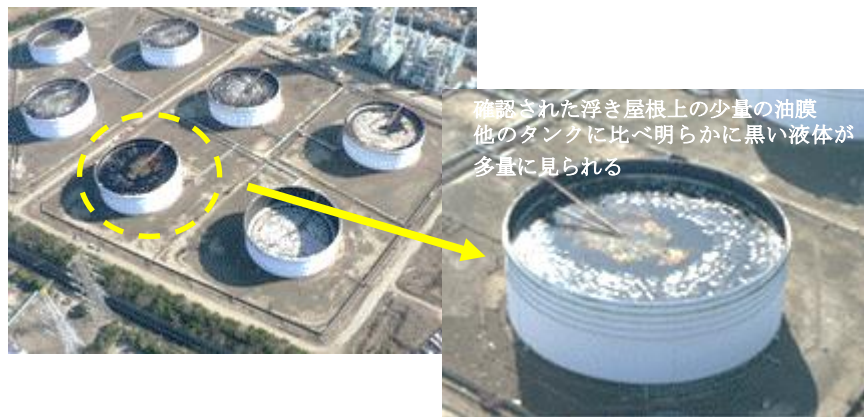
図 2.5.1 浮き屋根上に原油溢流疑いの事例
