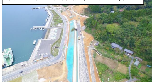
浦の浜漁港海岸磯草地区防潮堤
