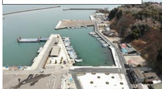
桂島漁港海岸桂島地区防潮堤
