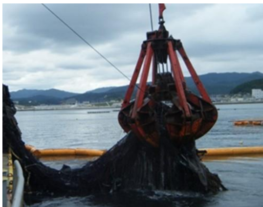
起重機船による漁場ガレキの撤去
