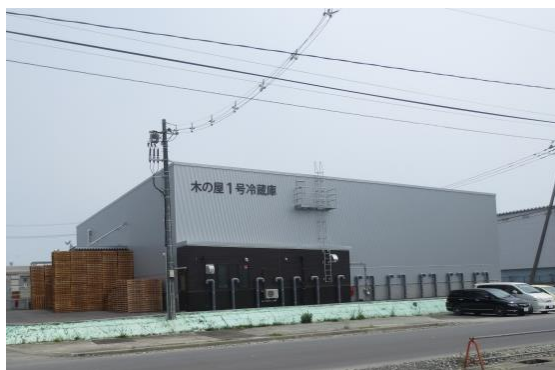
復旧した水産加工施設
