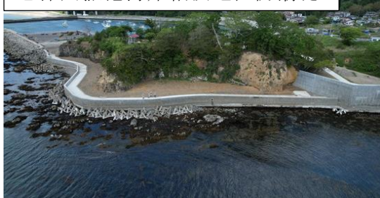
志津川漁港海岸袖浜地区防潮堤
