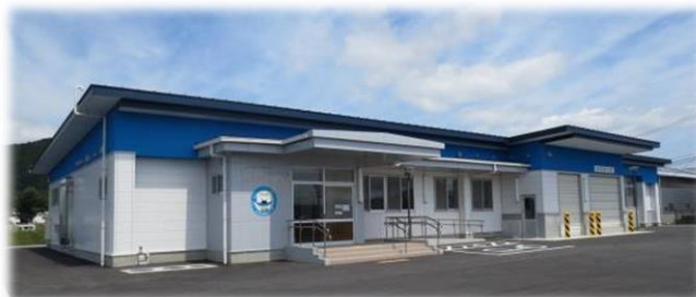
水産加工公開実験棟
