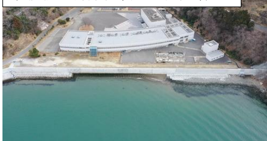
渡波漁港海岸佐須浜地区防潮堤
