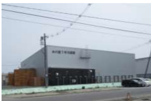
復旧した水産加工施設
