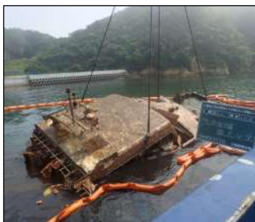
起重機船による漁場ガレキの撤去
