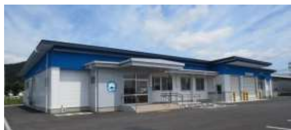
水産加工公開実験棟
