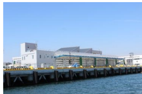
完成した塩竈市水産物地方卸売市場
