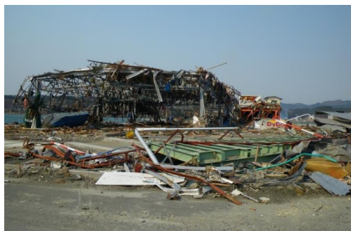
荷さばき所の被災状況
