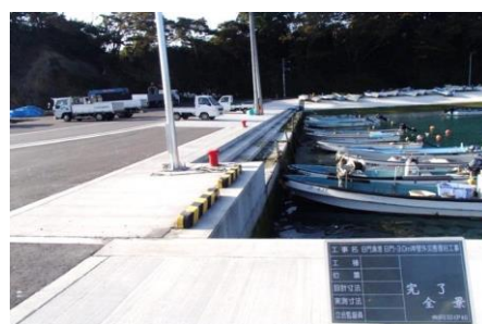
日門漁港 -3.0m岸壁 (平成27年度完成)
