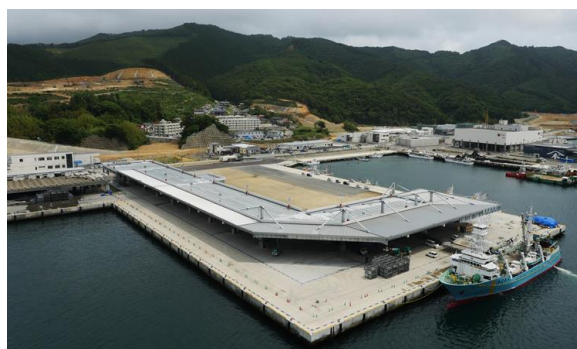
女川漁港 女川町地方卸売市場東棟
