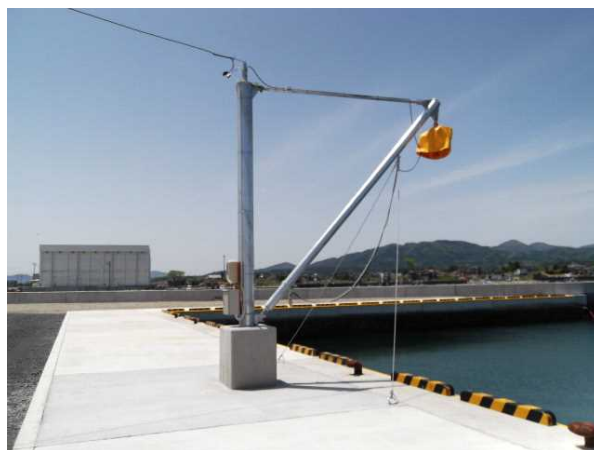
・作業改善が期待される荷揚用クレーン
