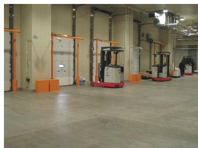
復旧した冷凍冷蔵施設
