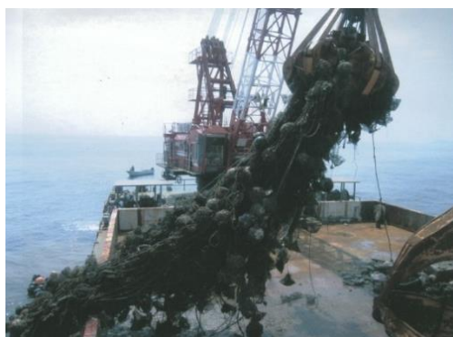
起重機船による漁場ガレキの撤去
