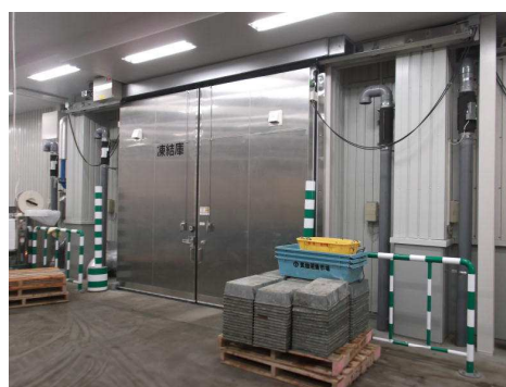
復旧した冷凍冷蔵施設
