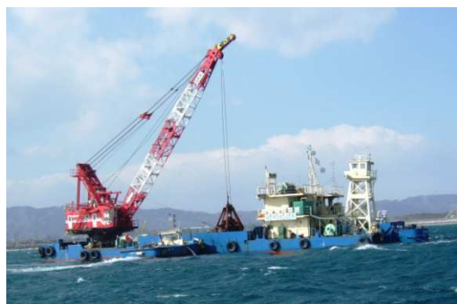
起重機船による漁場ガレキの撤去
