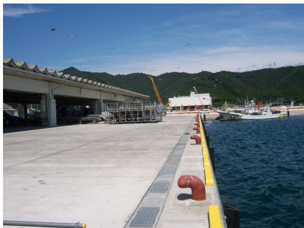
女川漁港 宮ヶ崎岸壁
