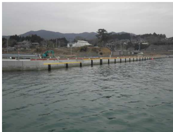
日門漁港 天ヶ沢物揚場
