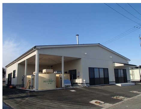
復旧したノリ加工施設
