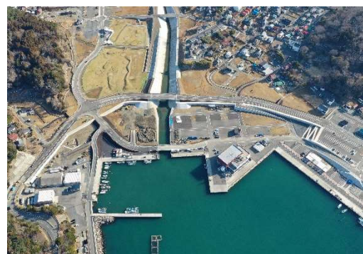
鮎川漁港海岸 R4.3月完成
