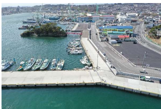
塩釜漁港海岸(新浜地区) R4.3月完成
