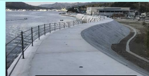
県民の命を守る防潮堤 ※気仙沼漁港海岸大浦地区防潮堤
