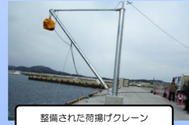
整備された荷揚げクレーン
