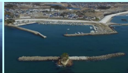
機能強化漁港の整備 ※菖蒲田漁港（七ヶ浜町）
