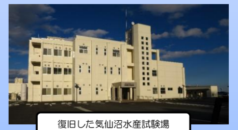
復旧した気仙沼水産試験場
