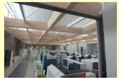
公共建築物で全国発の全体プロジェクト認証取得(南三陸町役場)
