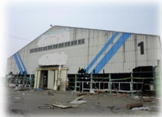
被災した木材加工施設
