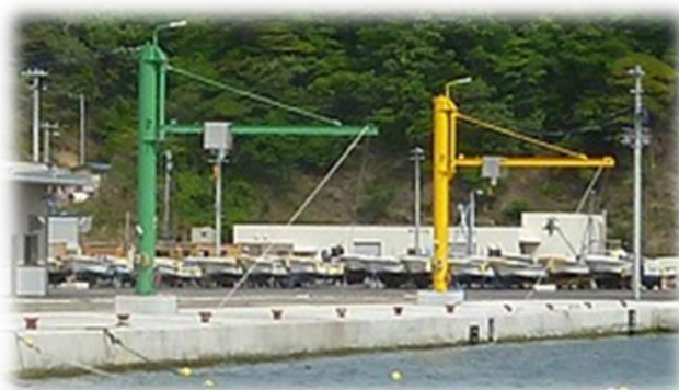
• 荷揚げ用クレーン
