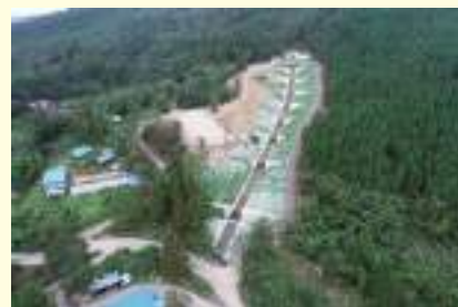
治山事業による復旧状況(山腹工)
