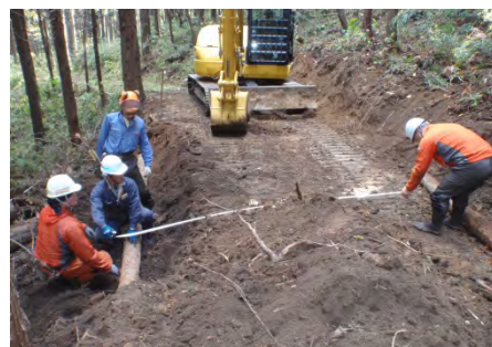
森林作業道作設ホーター研修（実習）
