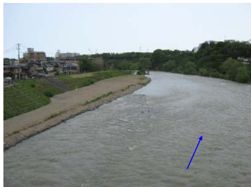
石河原の全面を洪水が流れる状況
