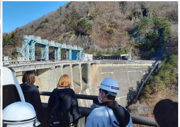
大倉ダムの堤体見学
