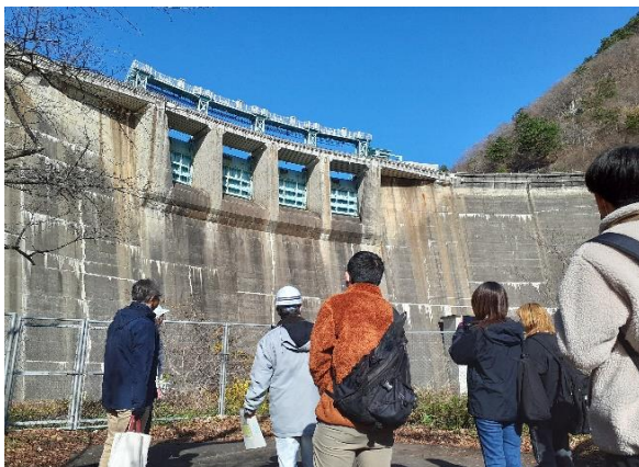
大倉ダムの洪水吐き見学
