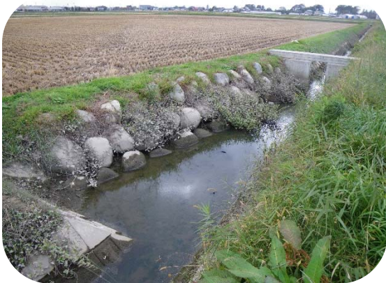
生きものに配慮して整備された石積み護岸
