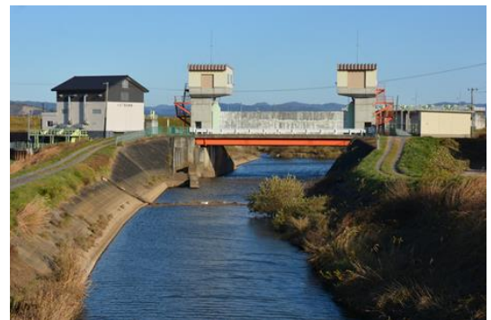
図 4-10 沼の水位を調整する飯土井水門
