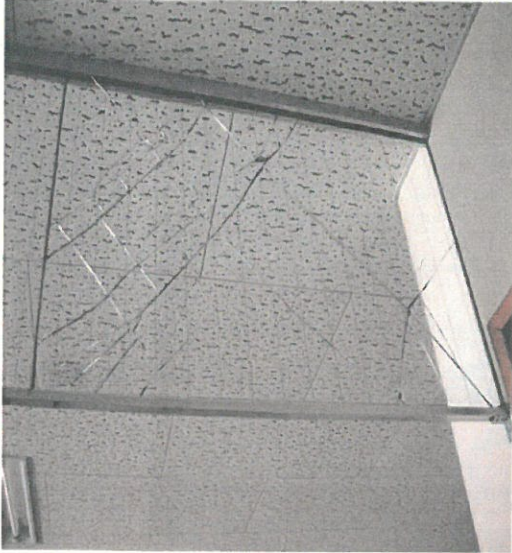
3階東側エレベーター前 たれ壁
