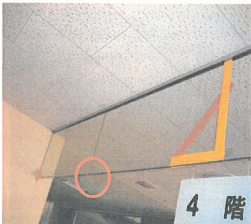
4階東側エレベーター前 たれ壁
