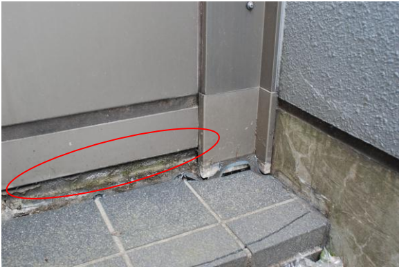
中庭沈下 全体的に5センチ程度沈下した
