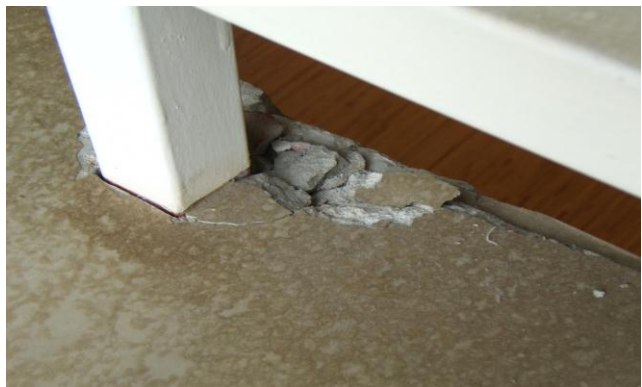
体育館ギャラリー手すり 揺れにより支柱部分の床コンクリが割れた
