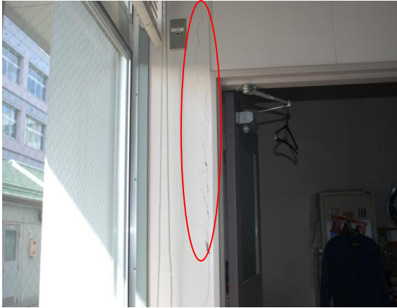
中庭沈下 全体的に5センチ程度沈下した
