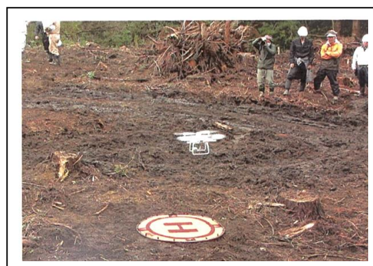
ドローン測量（研修会の様子）
