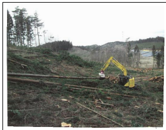
フェラーバンチャによる効率的な集材 (グラップル)
