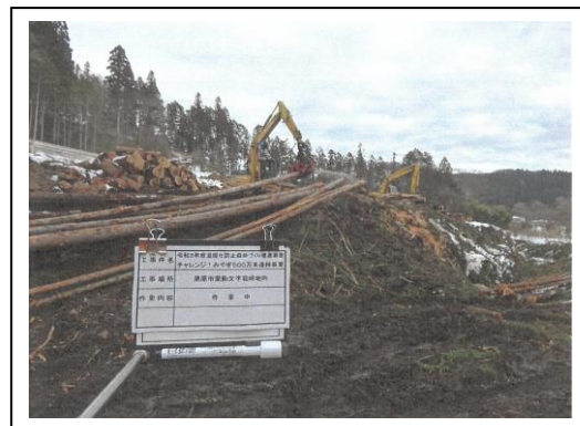
中間作業ヤードで枝払いし全幹
