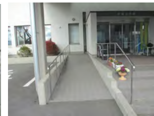
出入口の段差解消 事業費：30万円程度
