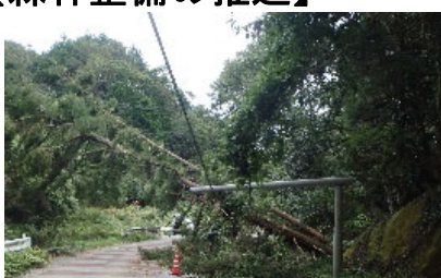
倒木により電線断線
