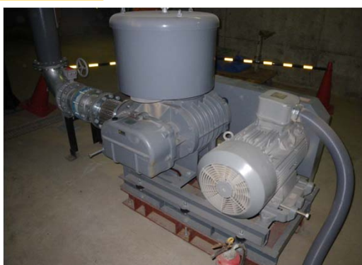
仮設フロアによる簡易曝気
