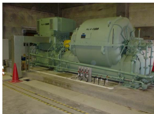
No.4-2送風機復旧・運転再開
