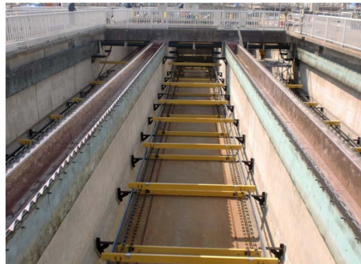
最終沈殿池復旧状況
