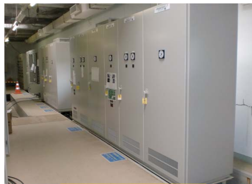
電気設備復旧状況
