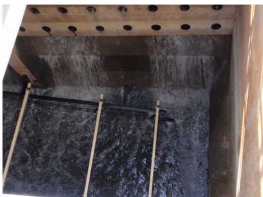
最初沈殿池流入開始状況
