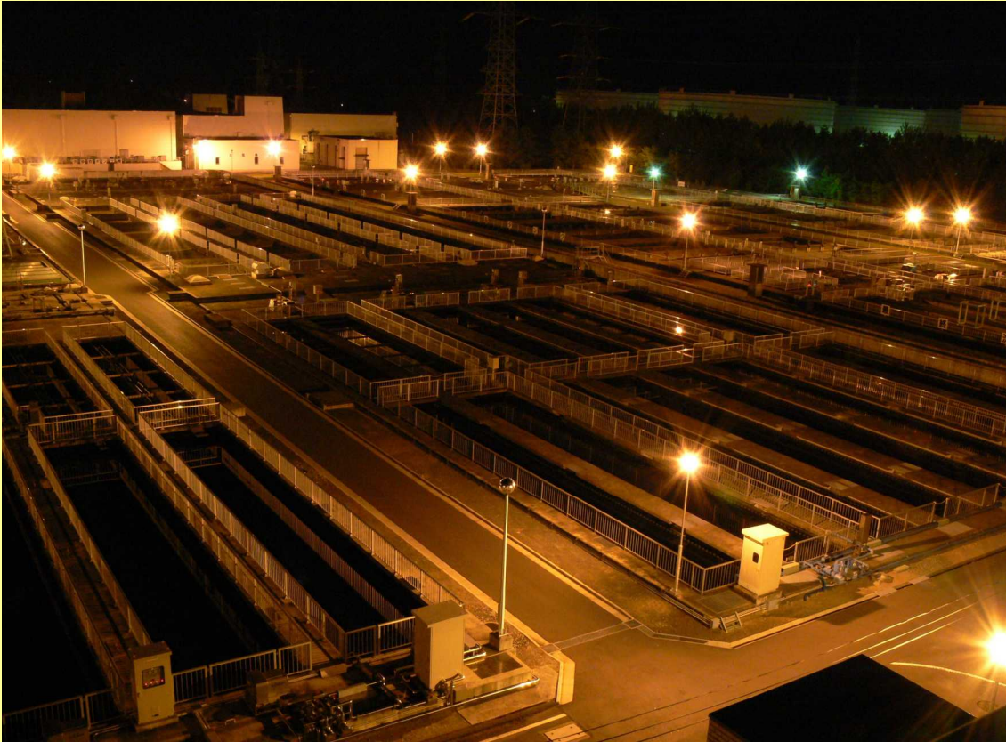
仙塩浄化センター管理棟より撮影
