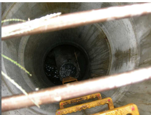
サイフォン部の状況確認
