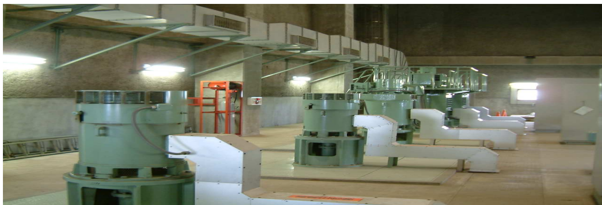
県南浄化センター汚水ポンプ室
