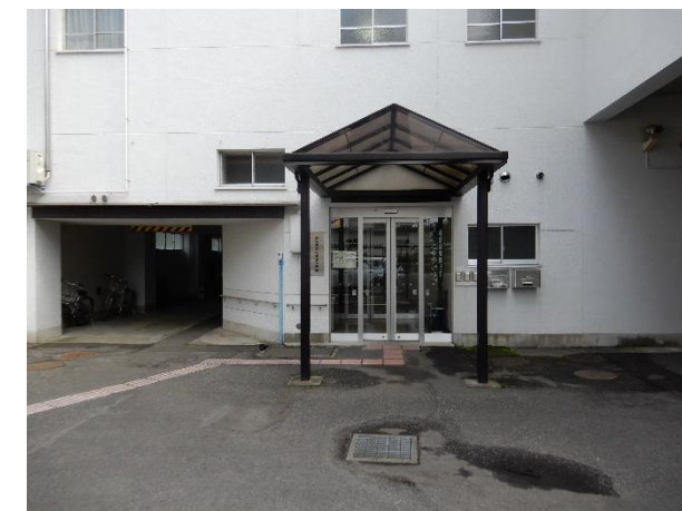
建物入口(北側)
