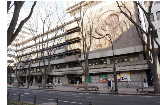
建物正面(南東側から撮影)
