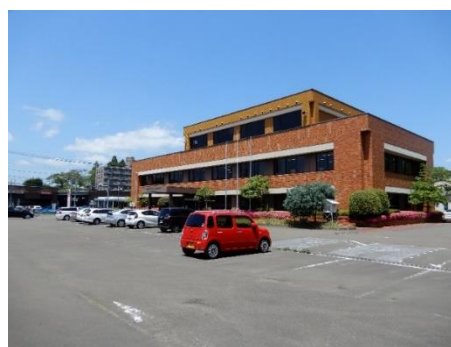
建物外観(東側から撮影)
