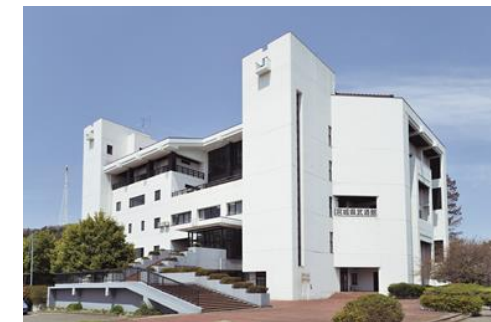
宮城県武道館
