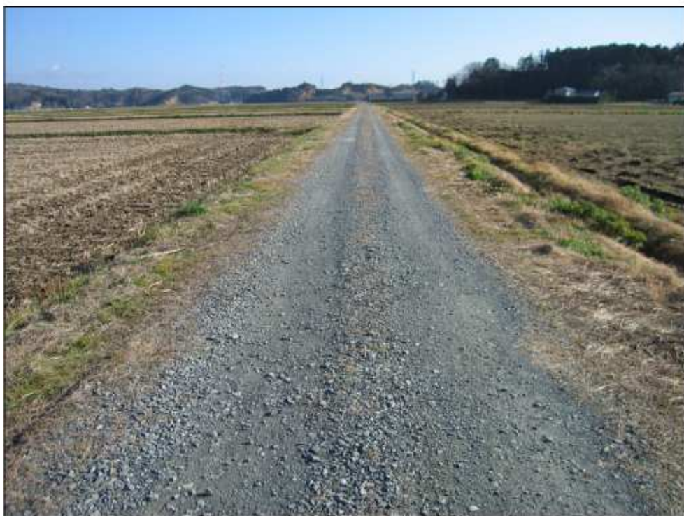
支線道路(区画整理後)
