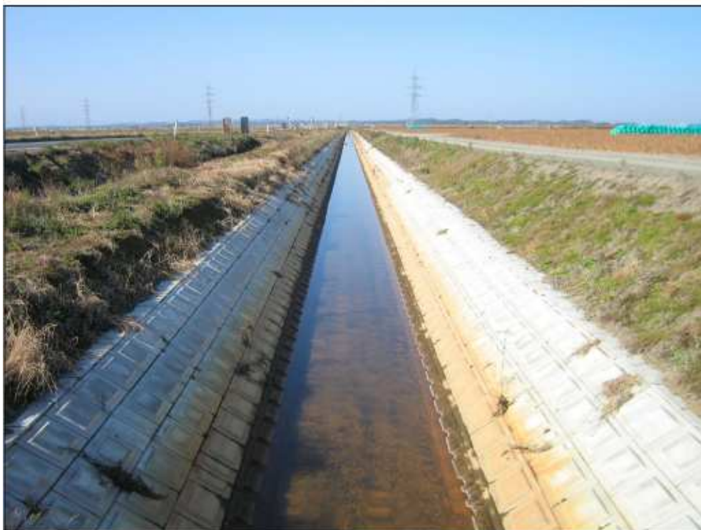
支線排水路(区画整理後)
