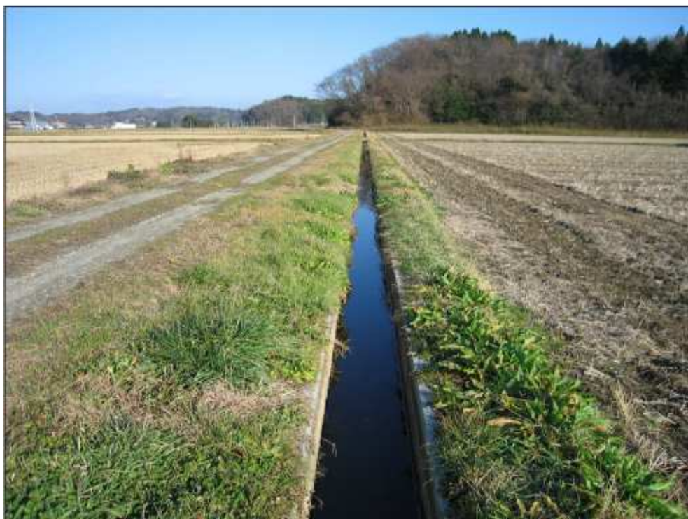
小用水路(区画整理後)
