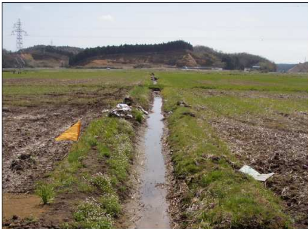
用排兼用水路(現況:区画整理前)
