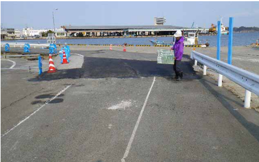
応急復旧(補修後)
