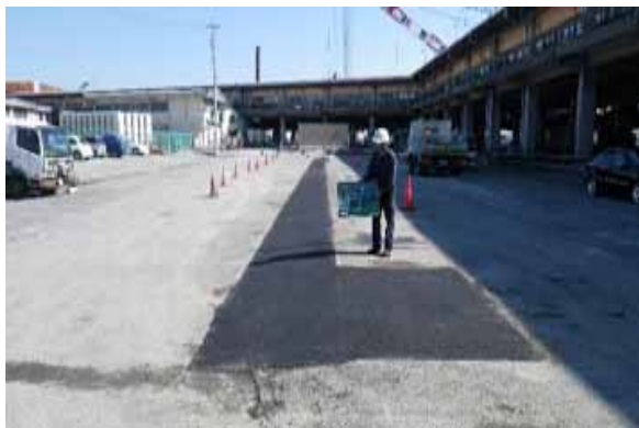
応急復旧(補修後)
