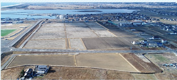
荒浜北部地区（亶理町）整備後の農地
