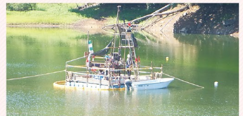
嘉太神ダム（大和町）における事業実施に向けた実施設計のためのボーリング調査
