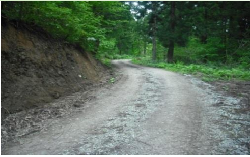
完成して利用可能となった林業専用道の区間
