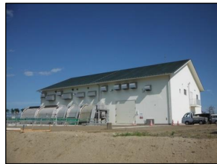
復旧した排水機場の1つ 二郷堀排水機場
