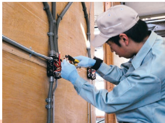
電線接続部の仕上げ作業をしています
