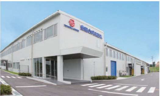
2015年6月に稼働した、宮城工場。中部、九州に次ぐ第3の自動車生産地域として期待される東北地域において、製品の現地調達ニーズに対応するとともに、地域の産業振興に貢献していく
