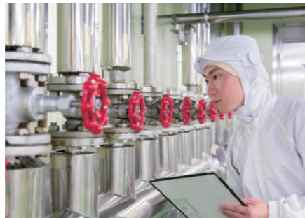
工場内の設備や配管の状態を隅々まで確認する。衛生環境面で工場をサポートするのが阿蘇さんの役割だ
