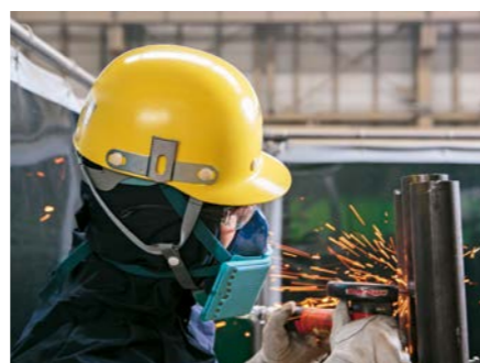
溶接した部分にやすりを掛ける。溶接した管は、実際の作業と同様に検査部門でチェックを受ける
