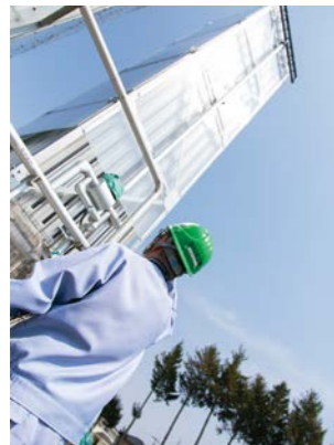
LNGを気化するための装置。3基あるうち2基を交替させながら稼働している
