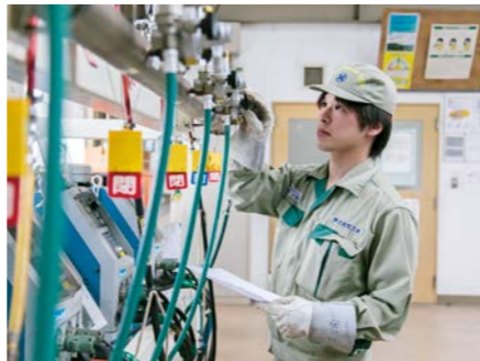
始業前の点検作業。電気溶接に使われる電気設備の状態をチェックする
