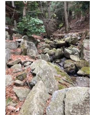
流れ石積み技法を用いた、小河川の改修事業
