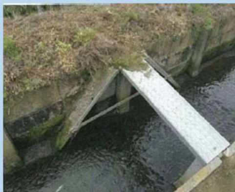
小動物移動機能付き水路の設置
