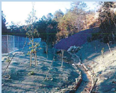
ビオトープ及び水路の設置
