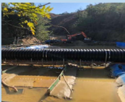
清水・濁水を分離した排水路を設置
