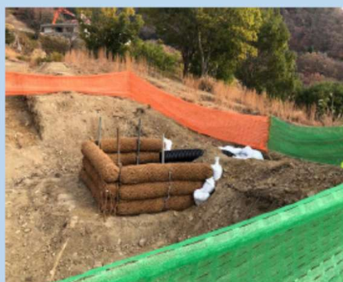
沈砂池とバイオフィルターの設置
