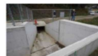
用水路の整備
